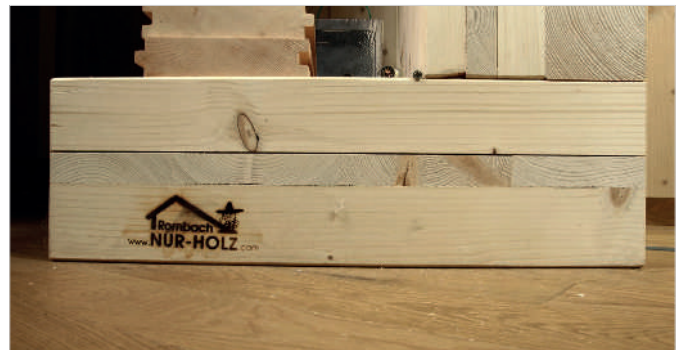
Ansicht eines NUR-HOLZ Modells mit 17,9 cm Bodenplatte.
