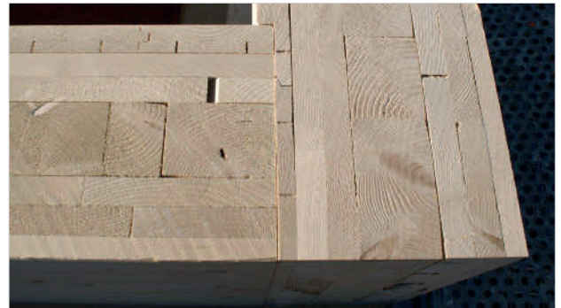
Eine Eckverbindung mittels Ausklinkung.
