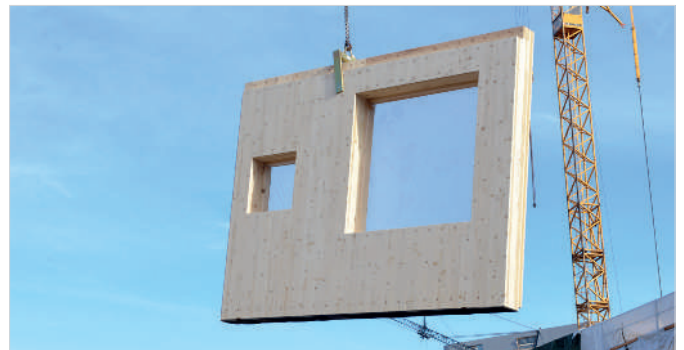
Eine fertig abgebundene 21,5 cm Wand am Kranhaken.
