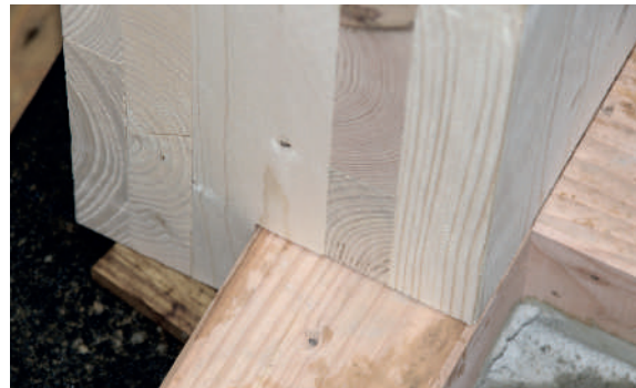
Fertig abgebundene Douglasien-Schwellen.
