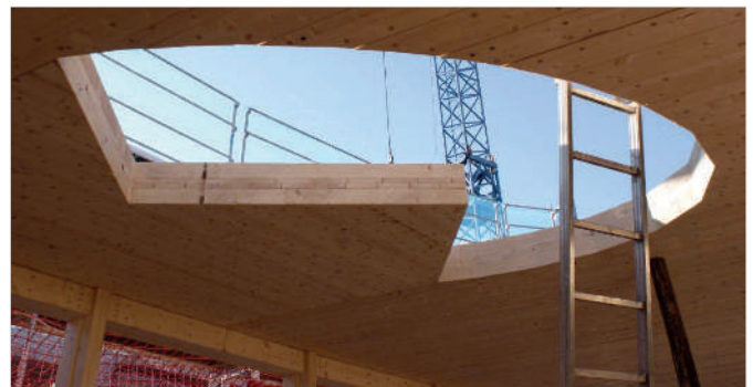
Das ausgeschnittene Treppenloch einer Wendeltreppe im Haus von unserem Vertriebspartner für Italien, Casa Salute.
