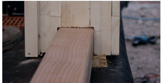
Die Montageschwelle wird bei größeren Wandstärken mittig gesetzt.
