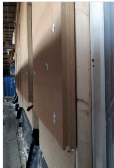
Direkt auf die NUR-HOLZ Wand aufgebrachte Holzweichfaser-Dämmung.
