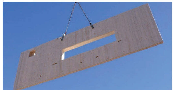
Ein fertiges Wandelement wird mittels Kran eingehoben.
